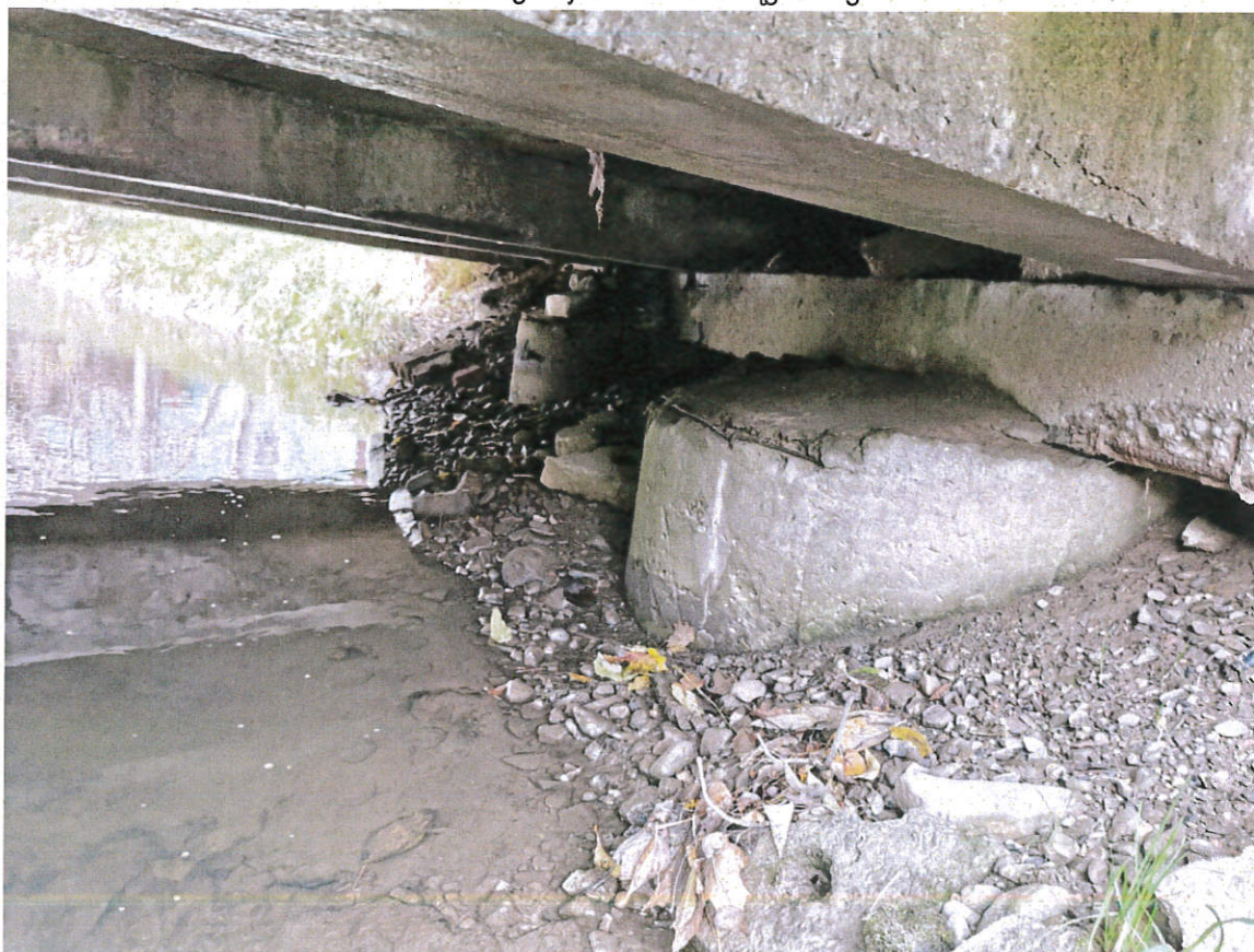
Widok na istniejące podpory mostu
