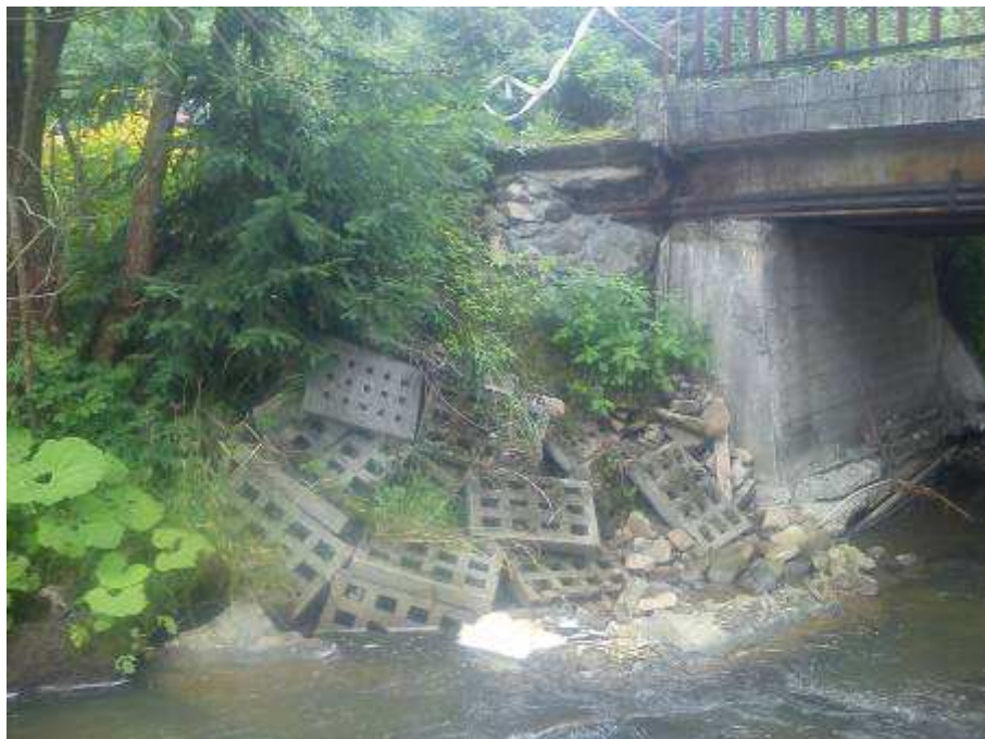
Fot. 7 Zniszczone umocnienie stożka i wypłukany nasyp na lewym brzegu od strony górnej wody.
