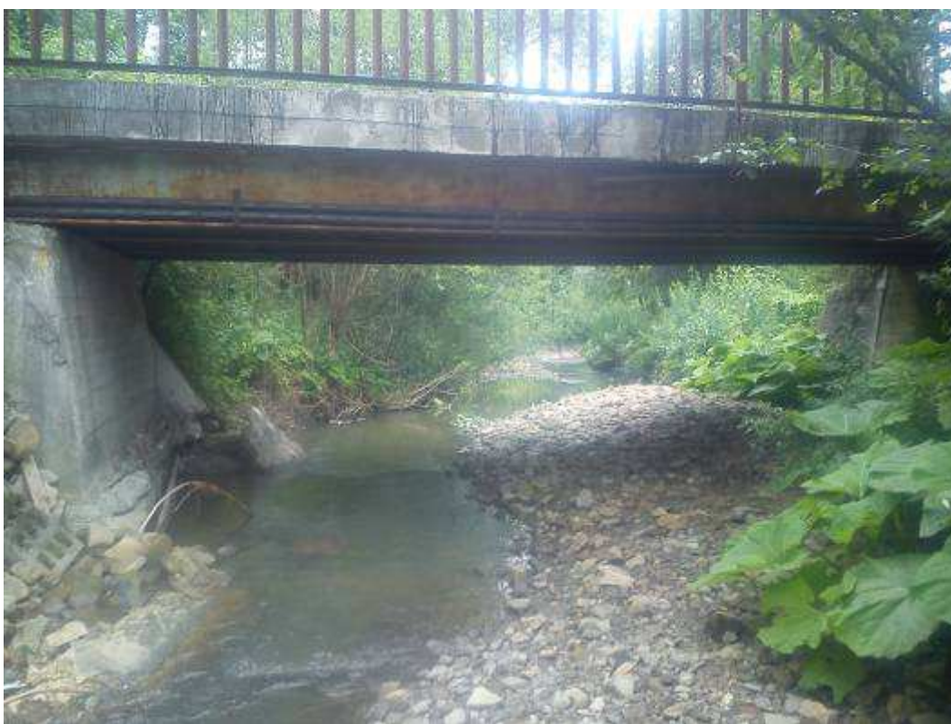
Fot. 6 Podmyty lewy przyczółek, odsłonięte studnie fundamentowe ubytki materiału w dnie.
