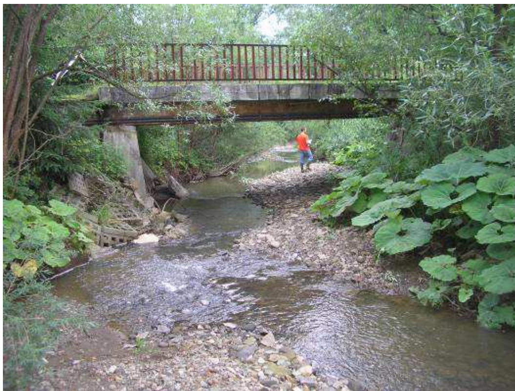
Fot. 9 Koryto potoku widok od str. górnej wody, widoczny skierowany główny nurt potoku w str. lewego stożka oraz przyczółka.
