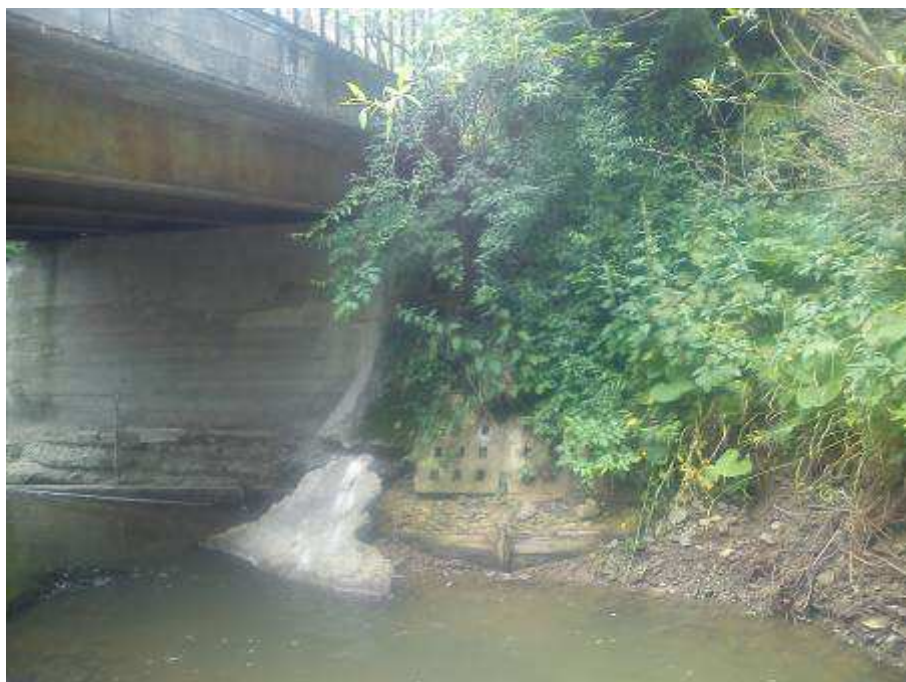
Fot. 8 Zniszczone umocnienie stożka i wypłukany nasyp na lewym brzegu od strony dolnej wody.
